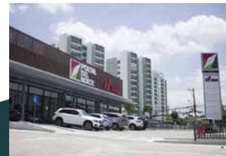
CONSTRUCCIÓN PLAZA PORTAL DEL NORTE SANTIAGO
