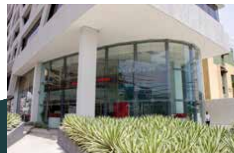
CONSTRUCCIÓN OFICINAS JMMB DOMINICANA, CORPORATIVO 2010 SANTO DOMINGO
