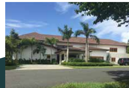
CONSTRUCCIÓN VILLA BARRANCA OESTE #38 CASA DE CAMPO
