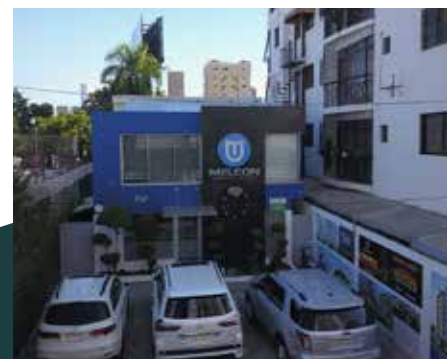
CONSTRUCCIÓN OFICINA MELCON SANTO DOMINGO
