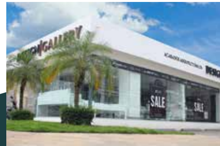
CONSTRUCCIÓN LOCAL COMERCIAL DESIGN GALLERY SANTO DOMINGO
